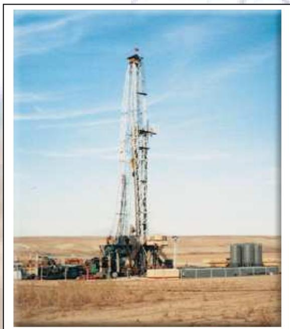
Une tour de forage est installée pour percer la roche à l'aide d'un outil rotatif appelé « trépan ». Une fois la poche de gaz atteinte, soit le gaz remonte tout seul si la cavité est sous pression, soit le gaz est remonté par injection d'eau ou de boue.
